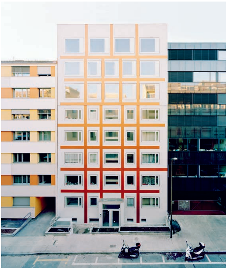
FAÇADE CÔTÉ RUE | FASSADE STRASSESEITE
