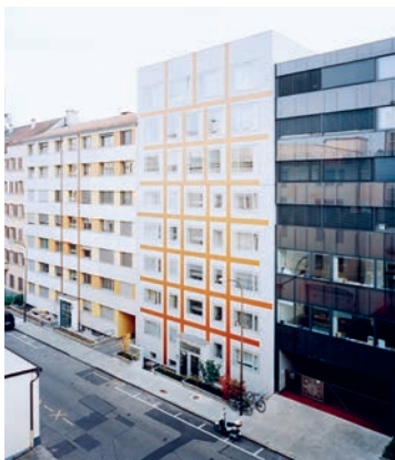
FAÇADE CÔTÉ RUE | FASSADE STRASSESEITE
