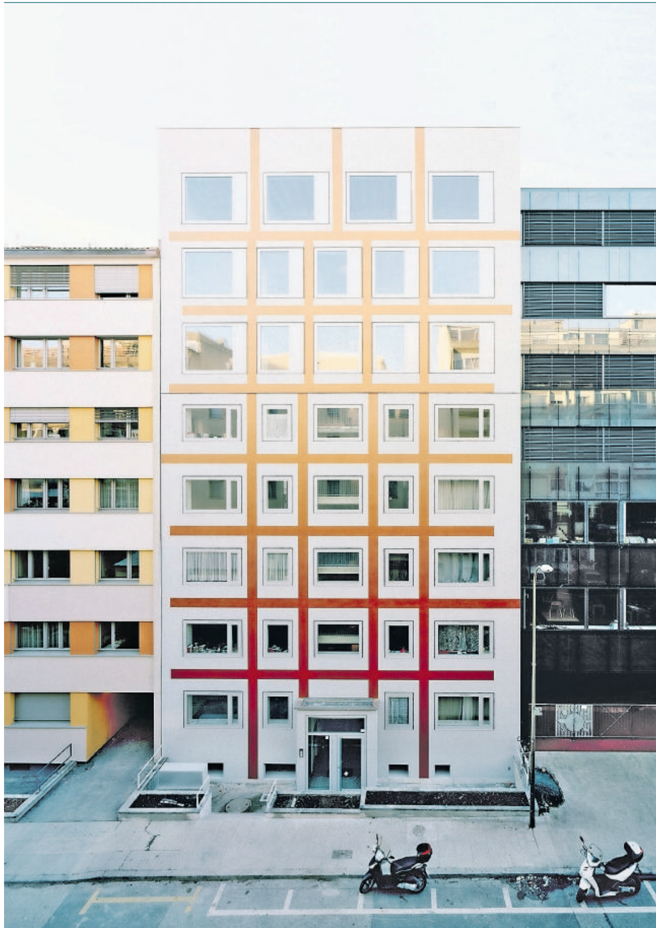
Kunst am Bau: Karim Noureldin gestaltete die Fassade im Zentrum von Genf
